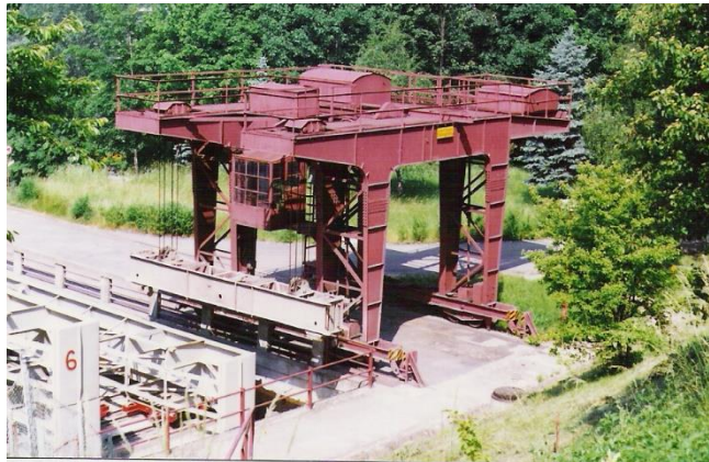
Obr. 3 Pohľad na portálový hradidlový žeriav
